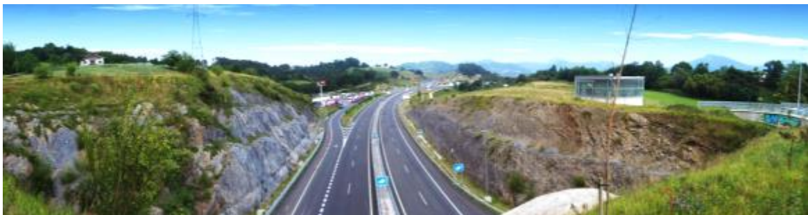
Figura 1.- Vista general del tramo de vial estudiado.
